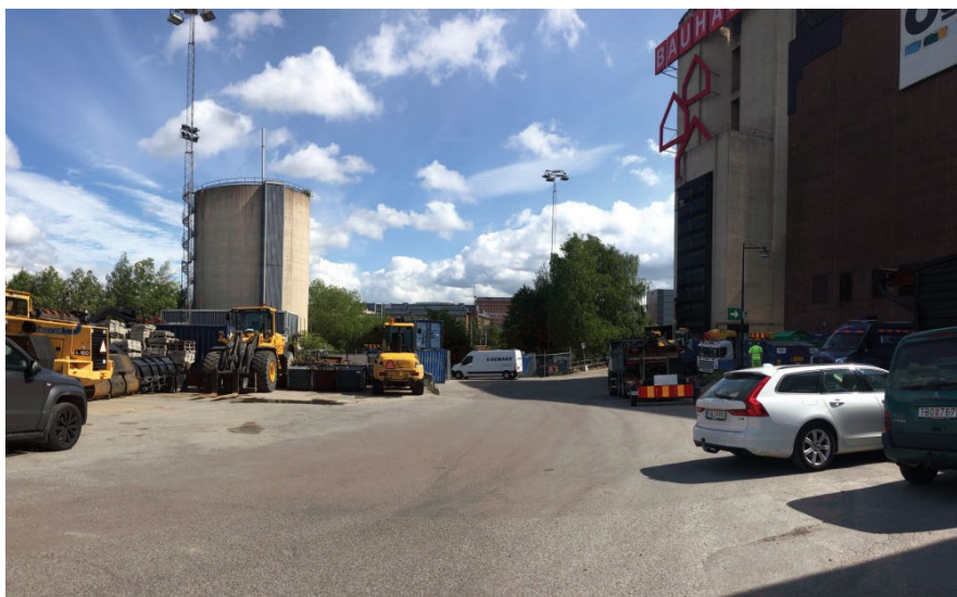
Befintlig vy mot Bällstaviken norr om det f.d. bryggeriet.
