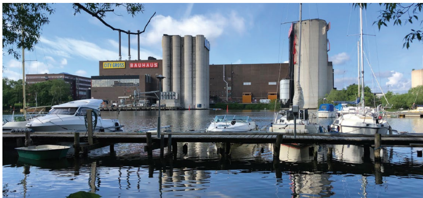
Befintlig vy över Bällstaviken från Solna mot f.d. bryggeriet.
