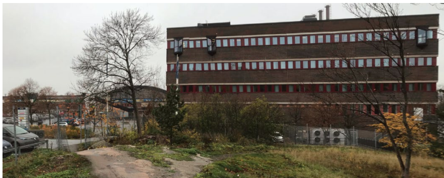
Befintlig vy från söder med kontorsbyggnaden i fonden och tapphallens karaktäristiska bågformade tak i bakgrunden.
