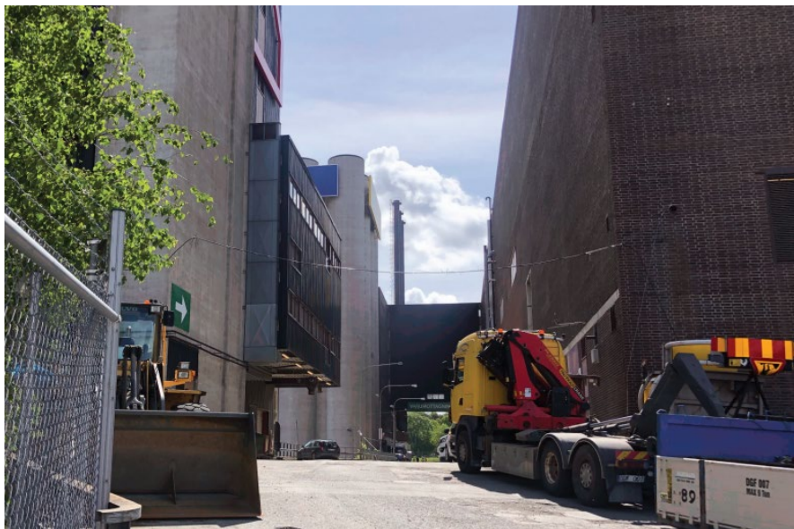
Befintlig vy från norr mot gränden mellan silosar och tankhus.
