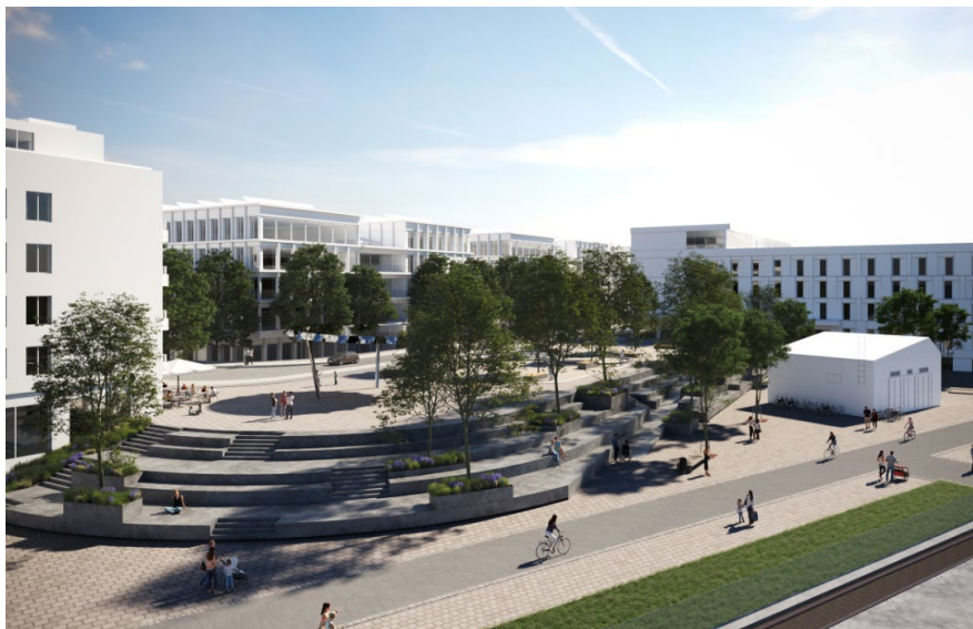
Parktrappan vid Norra Ulvsunda hållplats utgör en viktig samlingsplats.
